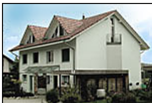
Niedrigenergiehaus in Lostorf / Solothurn
