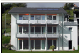
Passivhaus / Minergie P-Haus in Männedorf / Zürich
